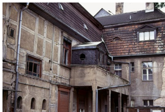
Die Sukka, die Familie Hirsch innerhalb des Messingwerkes Finow errichten ließ. Foto: Rainer Schluttig (Kreisarchiv Barnim, 2007).
